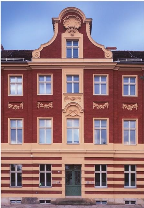
Haus Am Bassin 3
